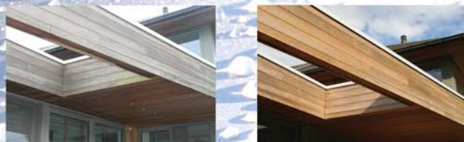
ceder gevelbekleding voor en na reiniging met NANODRY Wood Cleaner
